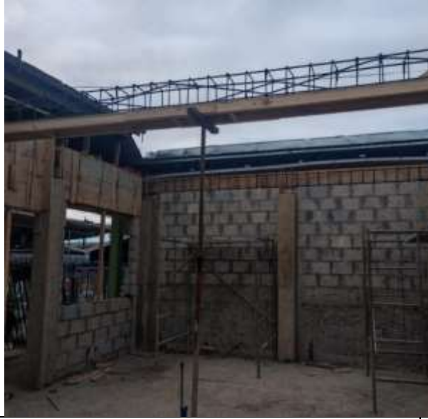
Vigas con varillas numero 4 estructurales corrugadas
