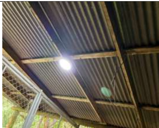
Mejoras en la caja de breakers e instalación de mas espacios en la misma.
