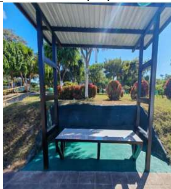
Construcción de parada de autobús nueva
