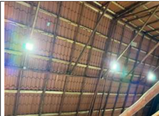
Mejoras en toda la luminaria
