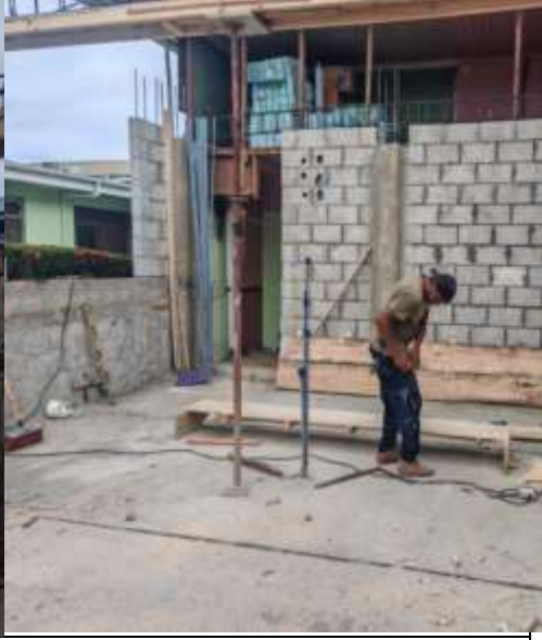
Columnas anchas con soporte listo para un segundo piso
