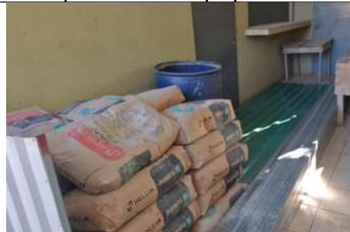
Acarreo de materiales ya que en este momento se está trabajando en eso.
