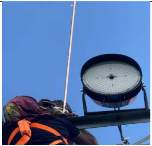
Instalación de luminarias
